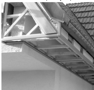
osazené ukonč. profily a první lamela
